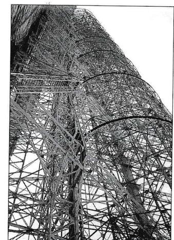
Jeklena konstrukcija odbojne stene radijskega teleskopa.
