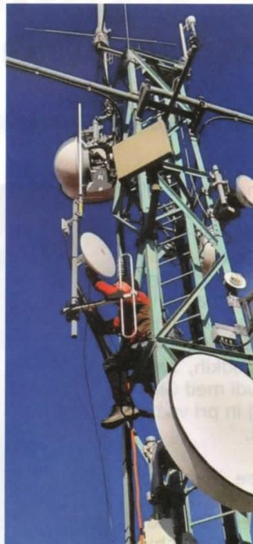
Slika 2: Montaža nosilca in anten na radijskem stolpu ARSO
