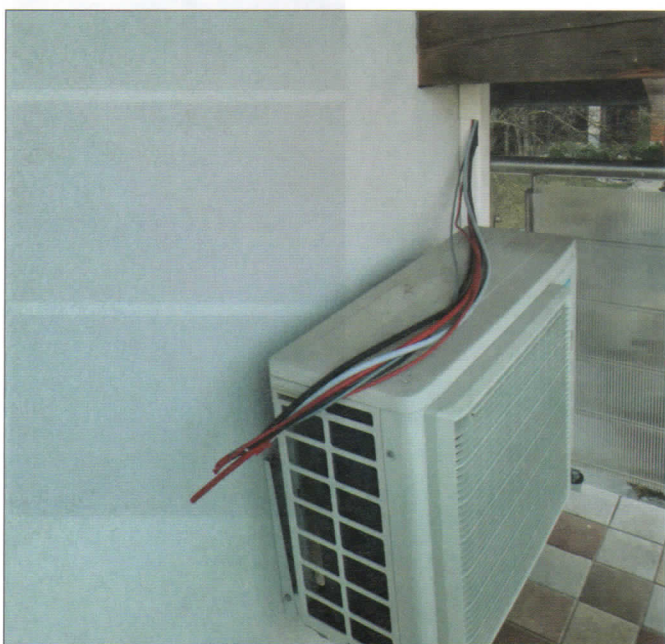
Vse kable sem pripeljal na mesto montaže inverterja. Vir: avtor
