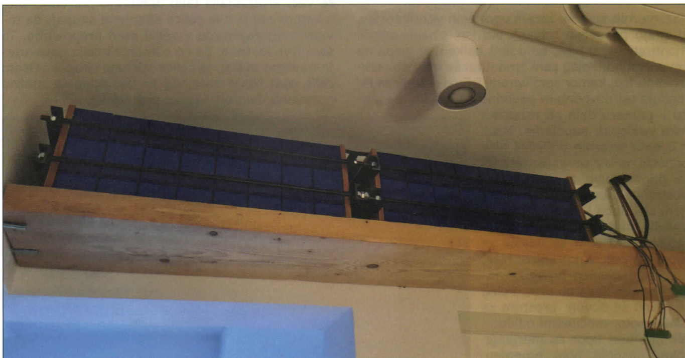
16 celic EVE280K s pripadajočo elektroniko nad preklado. Vir: avtor
