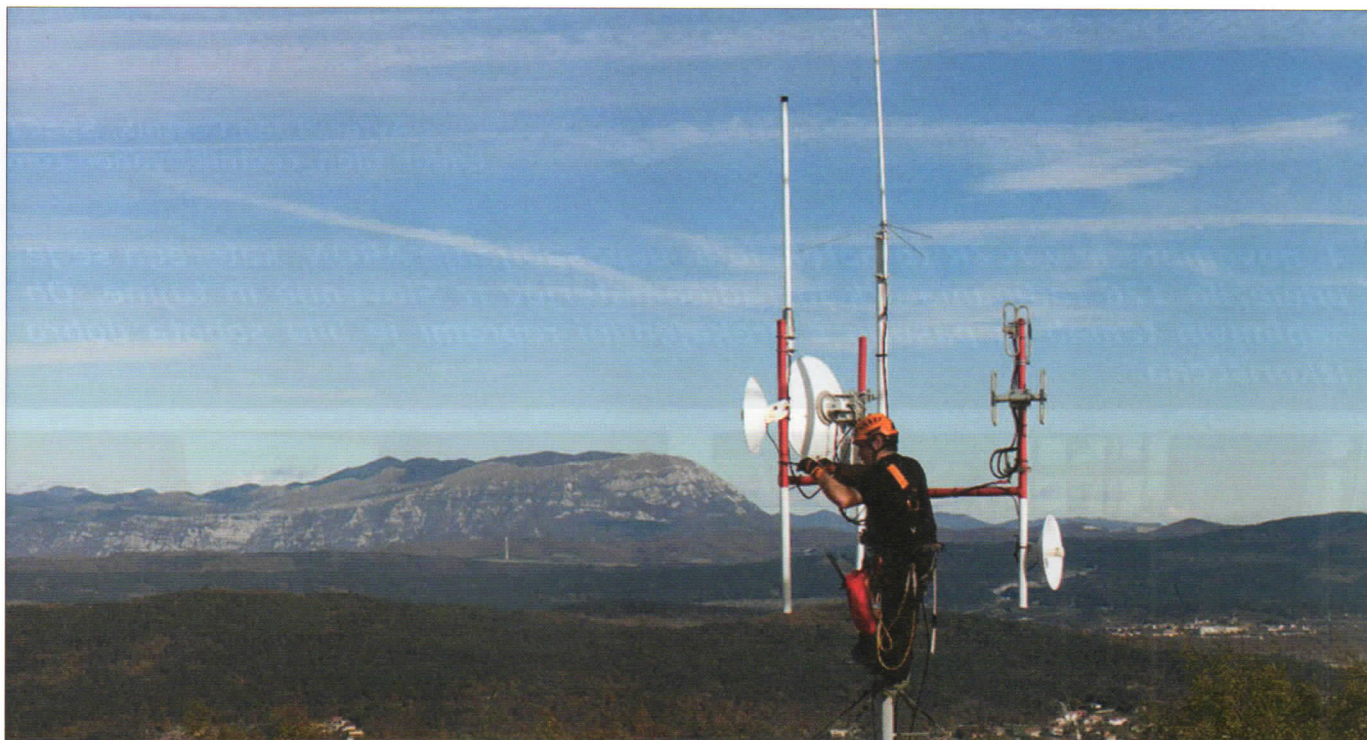
Fotografija 15: Montaža antene na Kokoški
