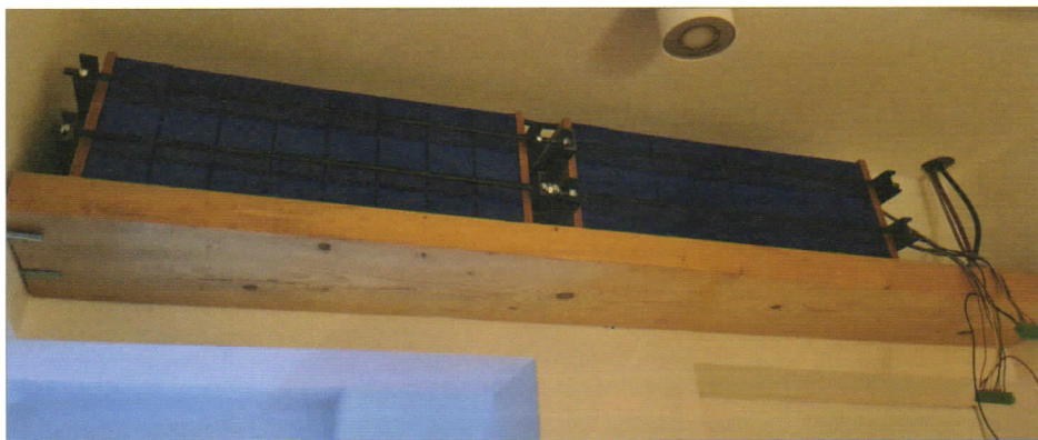
16 celic EVE280K s pripadajočo elektroniko nad preklado/ Vir: avtor
