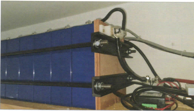
Izvedba kompresije celic z navojnimi palicami/ Vir: avtor
