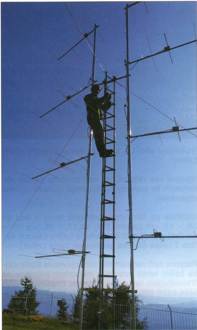
Slika 4: Postavljanje anten na tekmovalni lokaciji Roman S52EA
