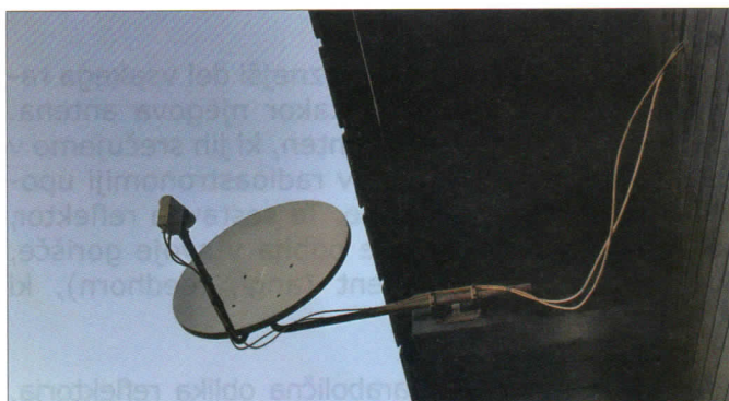
Slika 3: Parabolice antena in LNB
